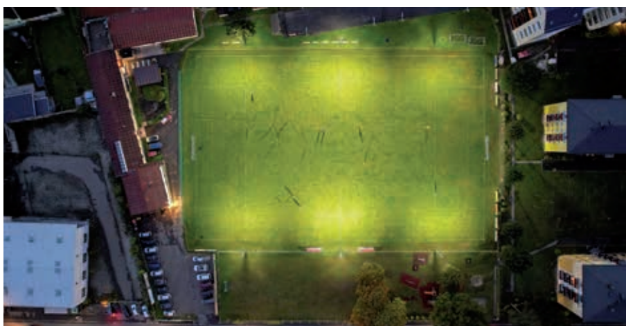
Die neue LED-Flutlichtanlage am ESV-Sportplatz in Leoben-Leitendorf wurde kürzlich in Betrieb genommen.
