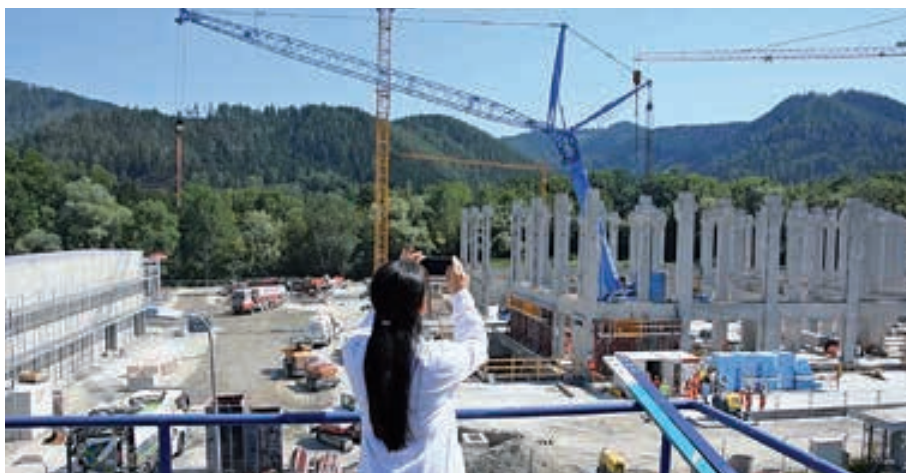
AT&S baut derzeit an einem weltweit einzigartigen Forschungs- und Entwicklungszentrum.
