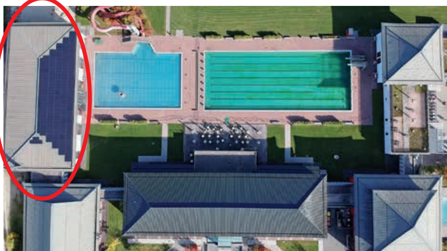
Die Photovoltaik-Anlage am Flachdach des Familienbereiches im Asia Spa Leoben (links im Bild ersichtlich) unterstützt nachhaltig die Stromversorgung.
