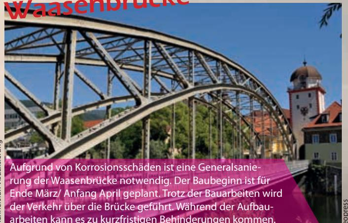
Aufgrund von Korrosionsschäden ist eine Generalsanierung der Waasenbrücke notwendig. Der Baubeginn ist für Ende März/ Anfang April geplant. Trotz der Bauarbeiten wird der Verkehr über die Brücke geführt. Während der Aufbauarbeiten kann es zu kurzfristigen Behinderungen kommen.
