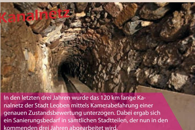
In den letzten drei Jahren wurde das 120 km lange Kanalnetz der Stadt Leoben mittels Kamerabefahrung einer genauen Zustandsbewertung unterzogen. Dabei ergab sich ein Sanierungsbedarf in sämtlichen Stadtteilen, der nun in den kommenden drei Jahren abgearbeitet wird.
