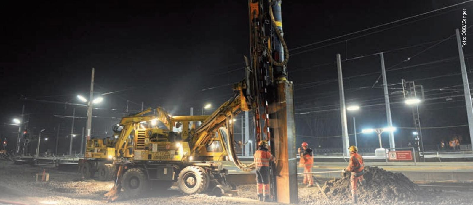
Im Bereich der neuen Haltestelle Leoben-Lerchenfeld werden Rammarbeiten für die neue Oberleitung durchgeführt.
