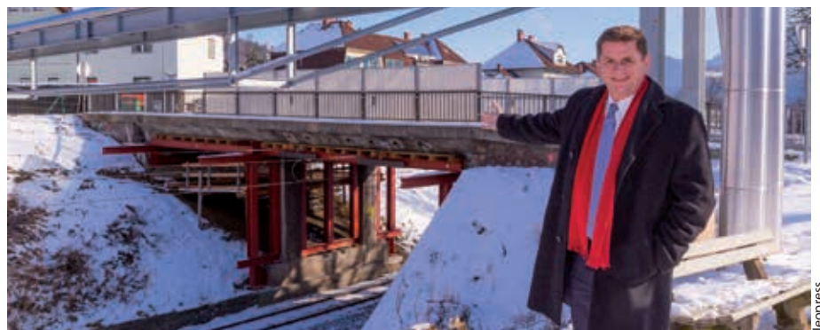
Bürgermeister Kurt Wallner hat sich um eine schnelle Sanierung der Brücke bemüht.
