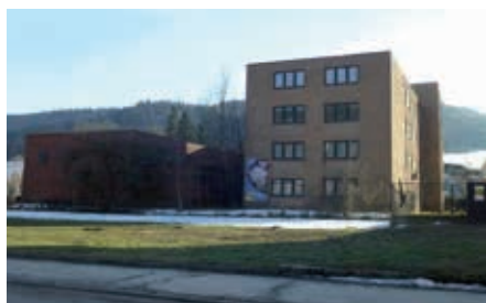
Die voestalpine startet im Frühjahr mit dem Abbruch des ehemaligen Lehrlingsheimes ...
