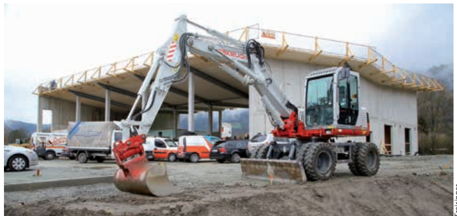
Neubau des ASZ am Prettachfeld. Im März folgt die Eröffnung.
