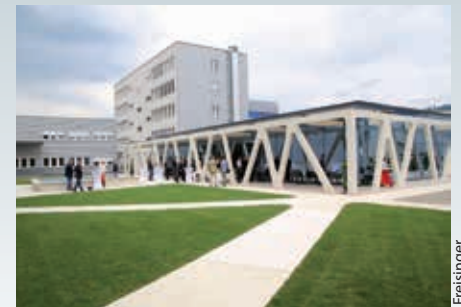
2.7.: Knapp im Logistik-Center Leoben eröffnet IV. Ausbaustufe.
