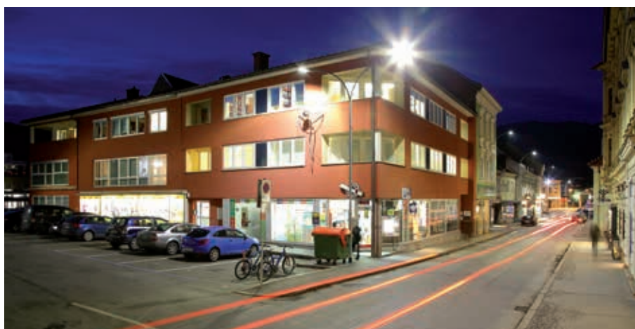
Seit letztem Jahr ist in Leoben-Waasen eine neue LED-Beleuchtung in Betrieb.
