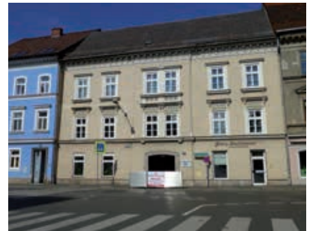
Bei der Musikschule werden umfangreiche Sanierungen durchgeführt.
