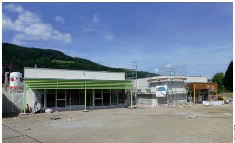
Die Bauarbeiten zum neuen Mitarbeiter-, Besucher- und Seniorenzentrum der voestalpine in Leoben-Donawitz schreiten zügig voran.
